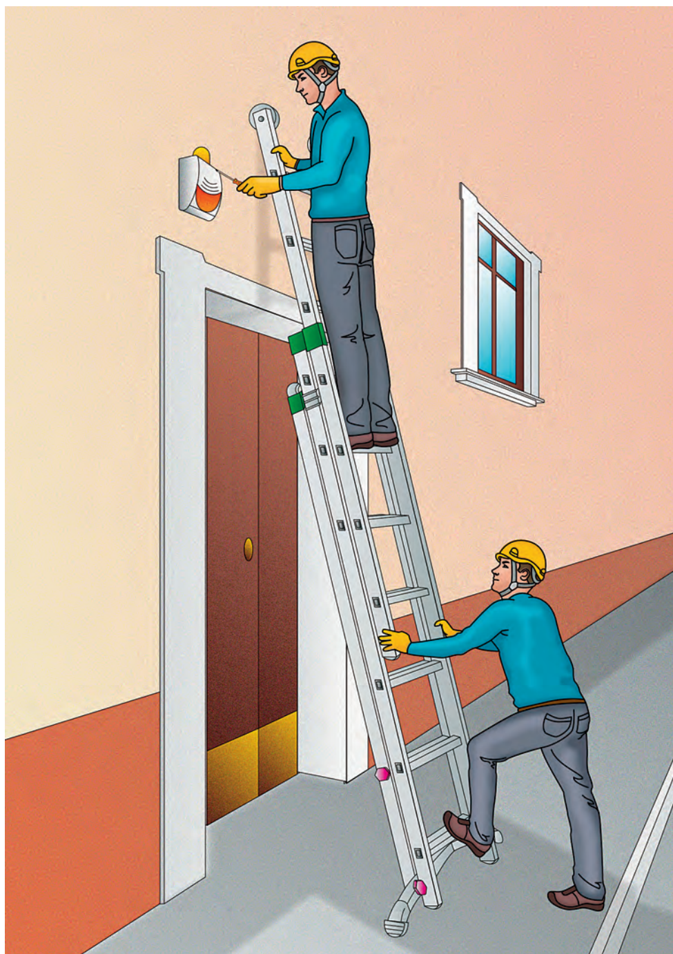
Figura 5 - Esempio di scala trasformabile a tre tronchi in configurazione di appoggio
